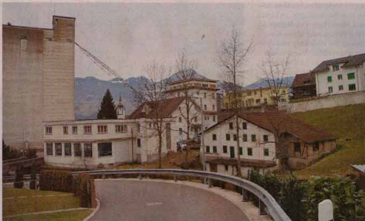
Das Areal der Obermühle von hinten: Das 40 Meter hohe Getreidesilo wird auf rund die Hälfte der Höhe reduziert und in Wohnraum verwandelt, die Produktionsräume (Mühle und Maismühle) weichen der neuen Überbauung. Bild Franz Steinegger
