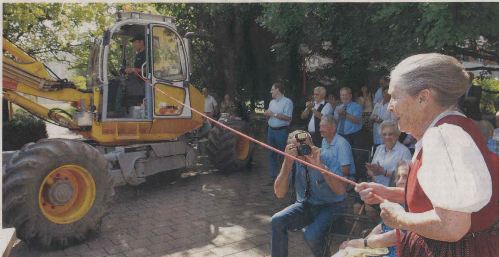
Altersheimbewohnerin Louise Dünki durfte mittels eines Seils das Zeichen zum Spatenstich geben. Im Jahr 1982 half sie mit, das Heim aufzugleisen. Bild: Heinz Diener
