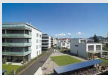
Neubau von 6 Mehrfamilienhäusern (62 Whg.) sowie 10 Reiheneinfamilienhäuser.
