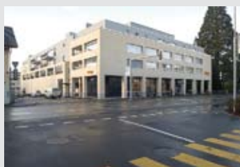
Neubau von 28 Eigentumswohnungen sowie COOP-Supercenter mit 1'800 m 2 Verkaufsfläche in Cham.
