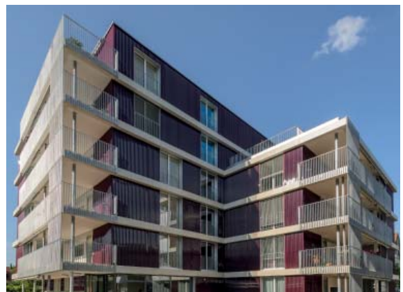
Neubau Hofächer mit speziellem Blickfang: Die hinterlüftete Fassade aus halbtransparenten Polycarbonat-Wellplatten.
