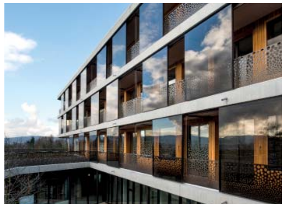
Neubau Tägerhalde: Wandverkleidungen und Türfurniere wurden aus Lärchenholz vom Küsnachter Wald verbaut.
