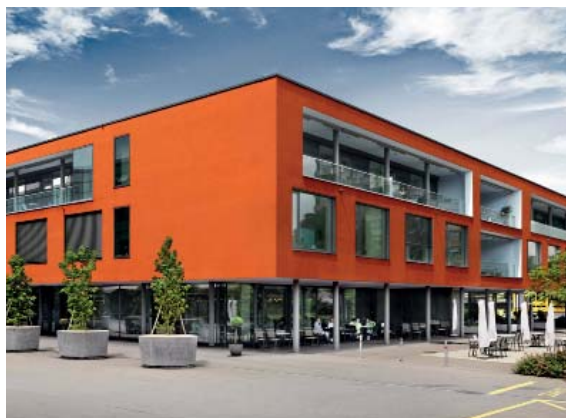
Nach nur 18 Monaten Bauzeit konnte das Pflegezentrum an die Betreiber übergeben werden.
