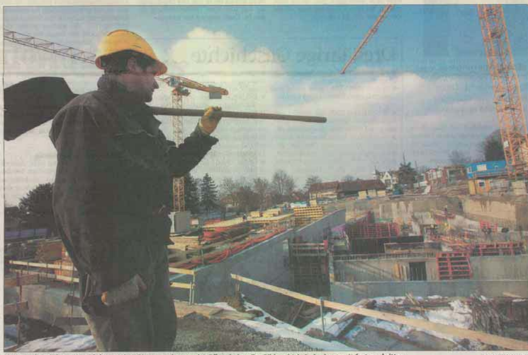
Der Bau der Tiefgarage und des zweiten Untergeschosses des Pflegeheims (im Bild rechts) sind schon weit fortgeschritten.
