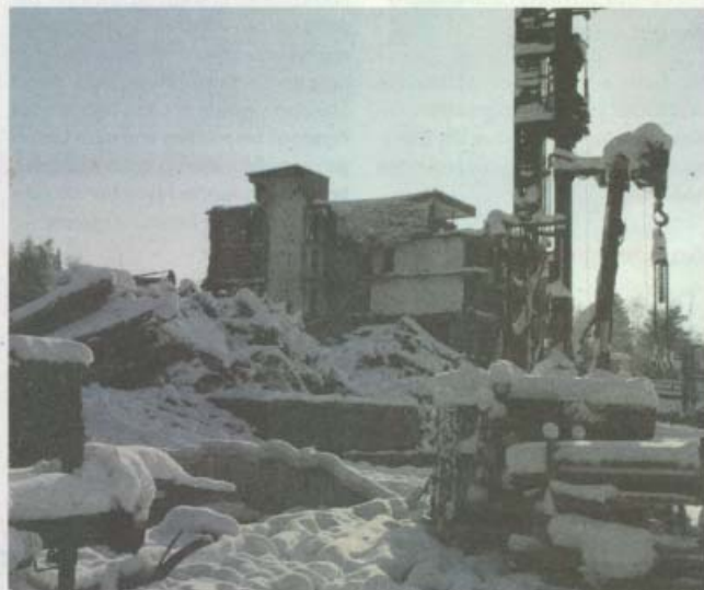
Die Abbrucharbeiten in der Tägerhalde sind in vollem Gange.
