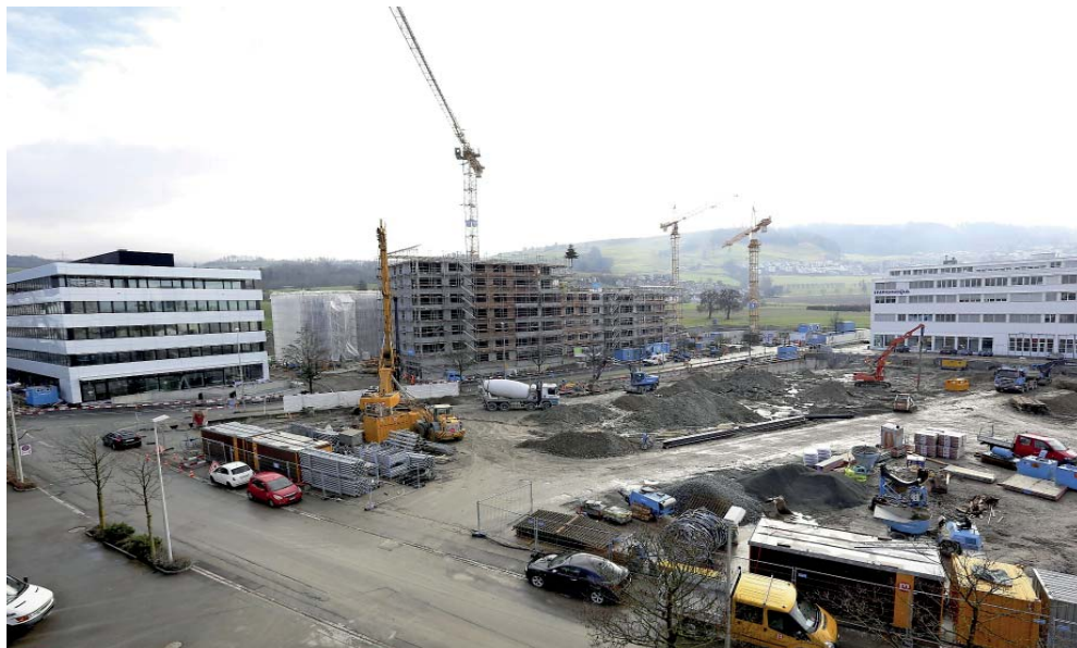
Im Vordergrund die Baustelle der Hiag Immobilien, hinten links der bereits fertig erstellte Neubau für die Glencore, und im Anschluss daran die neuen Überbauungen Baarermattpark sowie Huebweid, die von der Landis Bau AG und der Alfred Müller AG erstellt werden.
