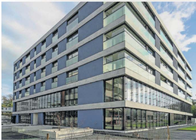
Der Neubau Grienbach steht an der Kreuzung Grienbach- und Inwilriedstrasse.
