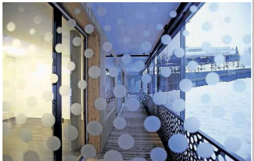
Der Balkon der Bewohnerzimmer hat ein vor Nässe und Kälte schützendes Schiebeelement.
